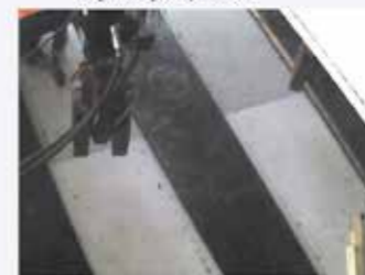
Контроль температуры при укладке литого асфальтобетона (t=210) с помощью тепловизора
