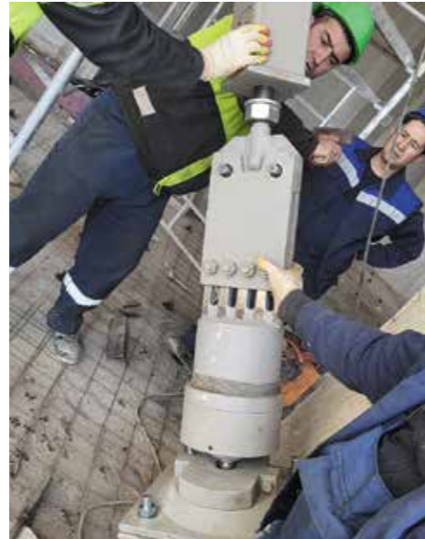
Монтаж демпфера-амортизатора с присоединительными элементами в здании гостиницы Приморская в Сочи
