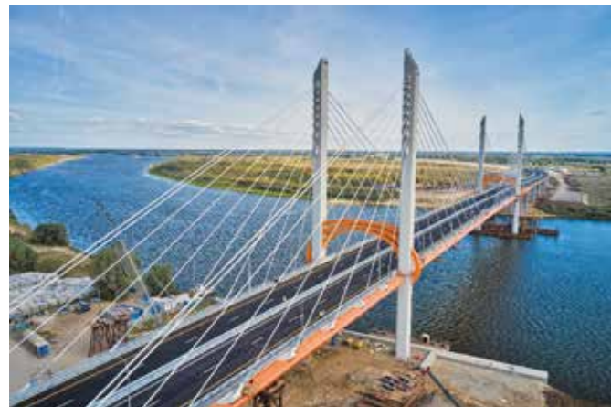
Мост через Оку на трассе М-12 «Восток»
