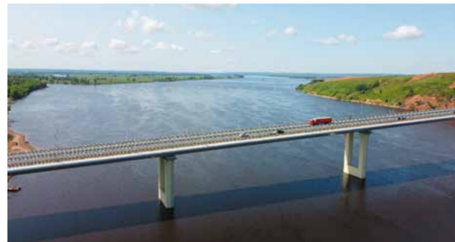
Мост через Каму на обходе Нижнекамска и Набережных Челнов
