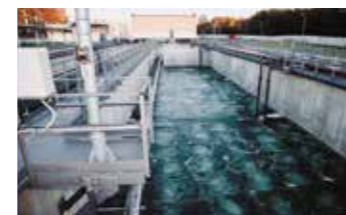
Резервуары с питьевой водой
